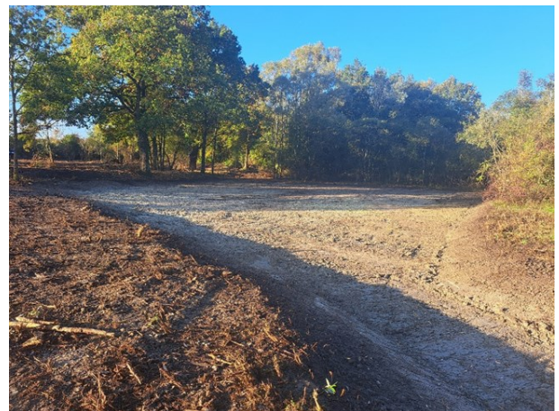
Zone décaissée qui deviendra une zone humide à Chitenay
