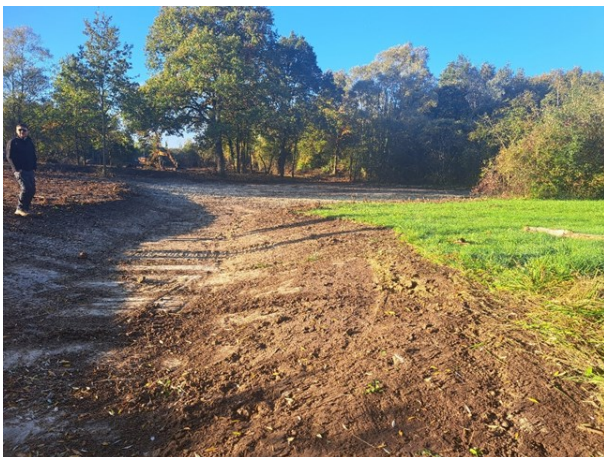
Noue permettant l'alimentation de la zone décaissée qui deviendra une zone humide à Chitenay
